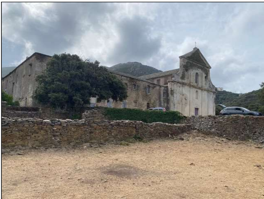
Fig. 8 – Couvent de l'Annunziata faisant l'objet d'un projet de réhabilitation (parcelles A-868 et 869)
