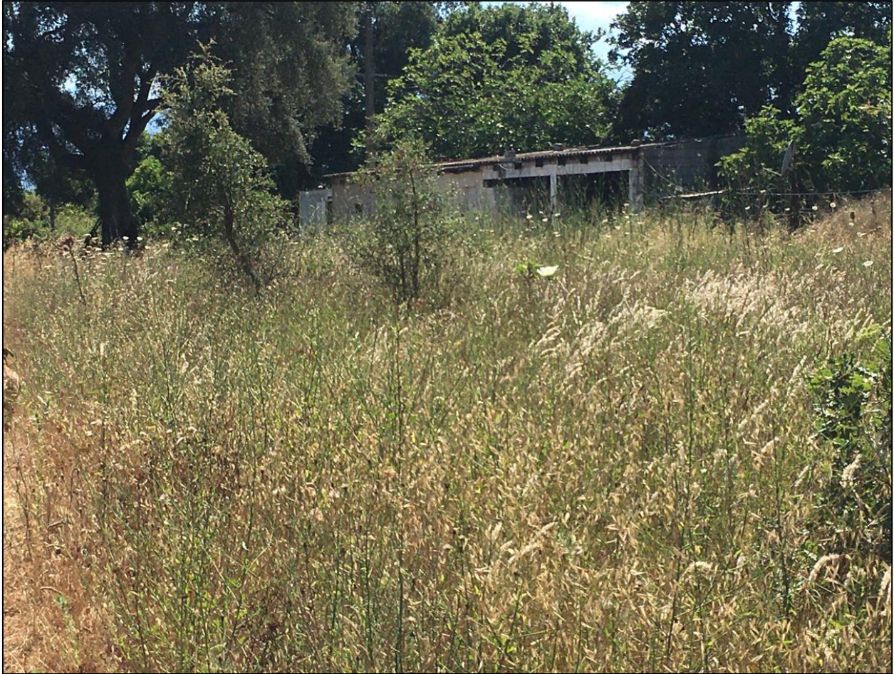
Photo 2 : Bâti existant à l'extrémité nord-ouest de la parcelle C 3015
