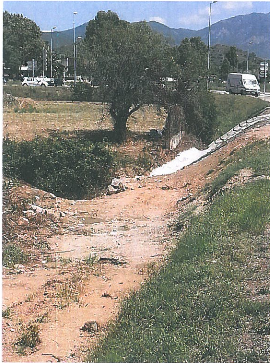
Aménagement amont après travaux d'urgence
