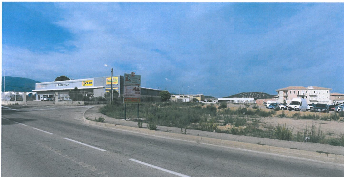
Zone d'implantation dans son environnement lointain
