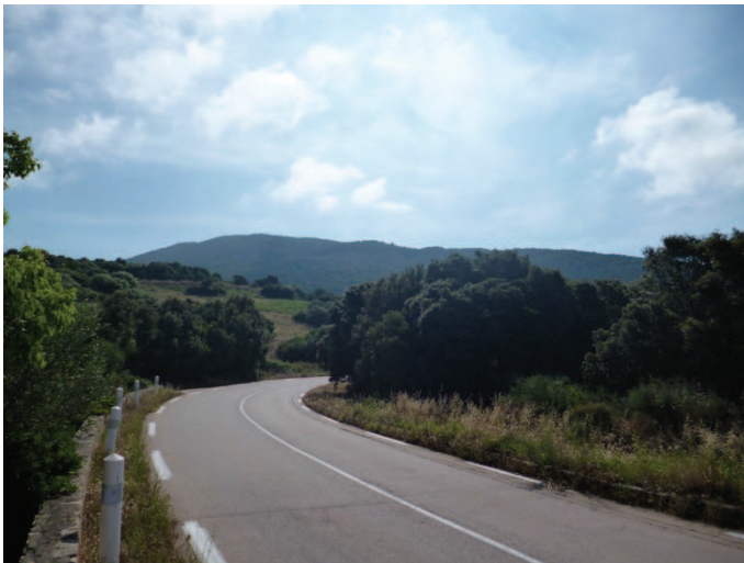
PHOTO 1 (RT 40 au droit du projet)
