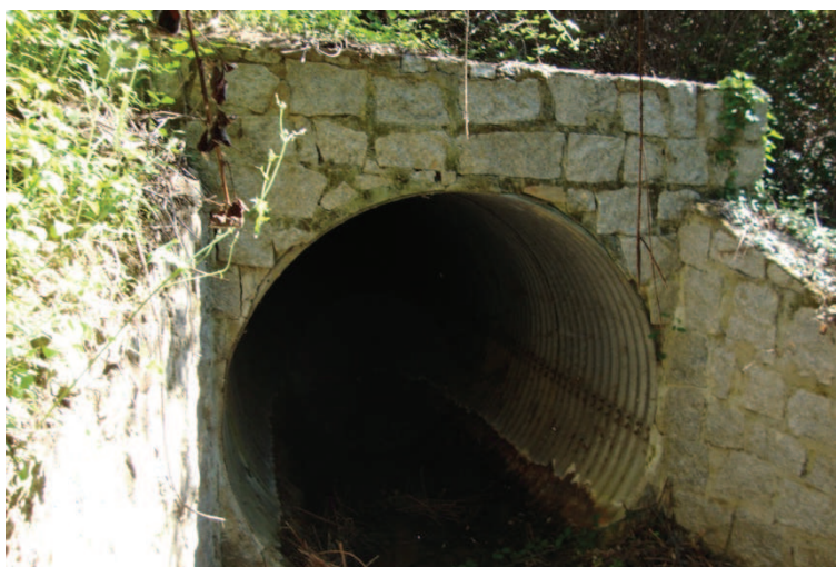
PHOTO 6 (tête aval de la buse)
