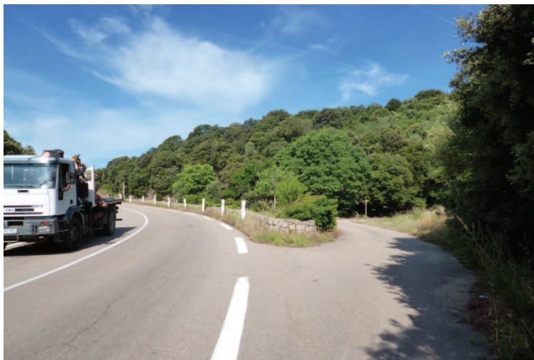
PHOTO 5 (Accès au délaissé de route, aire de repos)
