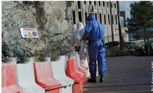
Figure 1 : Exemple de délimitation du chantier et mise en place de la signalétique (INRS)
