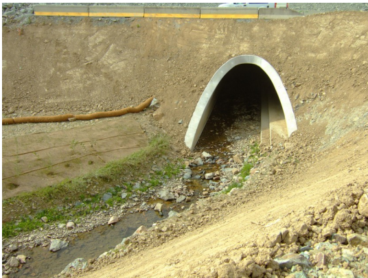
Crédit photo : Cerema Passage inférieur mixte (ouvrage de franchissement hydraulique avec aménagement d'une banquette pour la faune)
