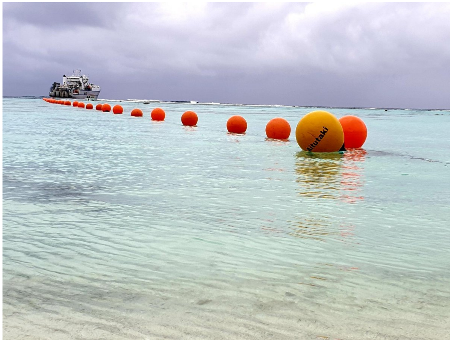
Figure 2 : Exemple de tirage d'un câble depuis un navire câblé vers la plage (Source : SUBCOM)
