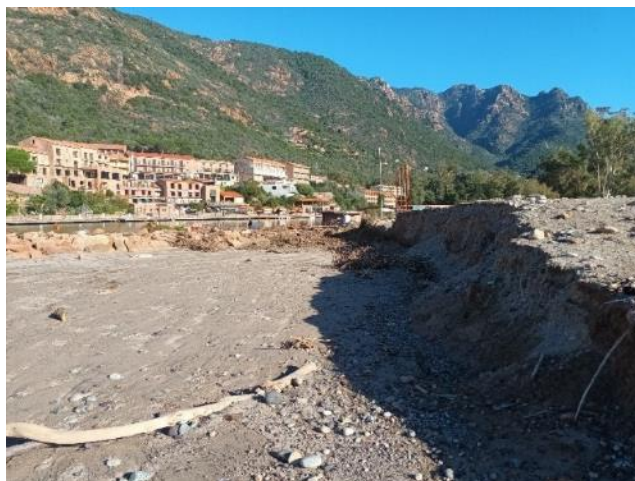
Figure 4-1 : Prise de vue de la partie nord de la plage de Porto, adjacente à l'épi, fortement érodée par la crue du Porto
