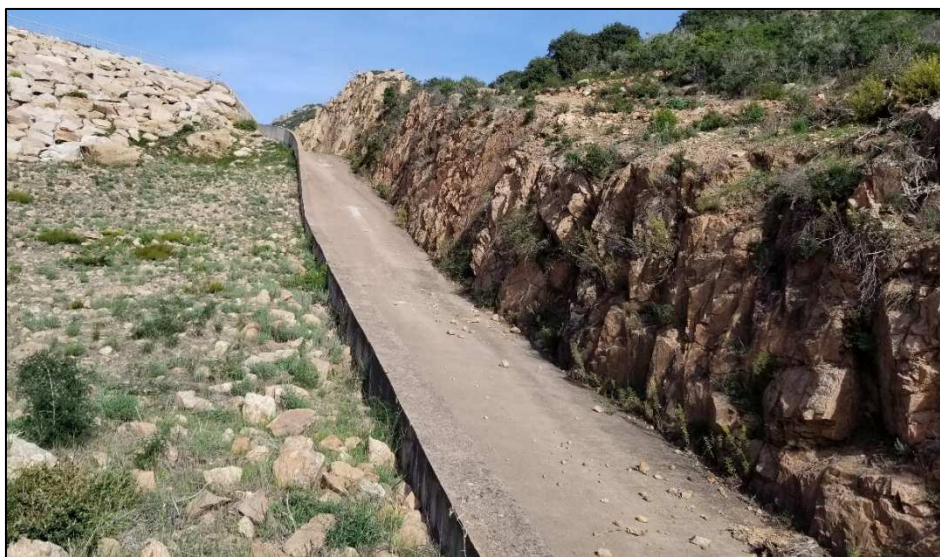
Evacuateur de crues du barrage de Figari (ENDEMYS, 2022)
