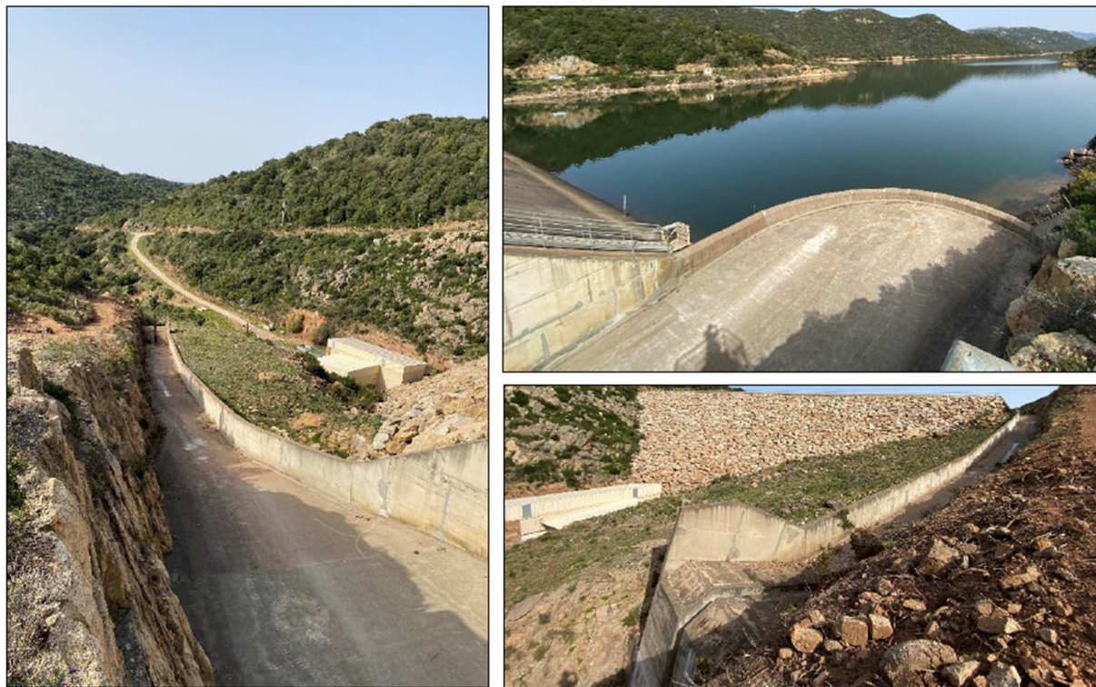
Photo 4. Evacuateur de crues du barrage de Figari
