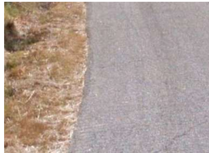
Exemples de portions d'enrobé avec accotement à niveau sur la D238
