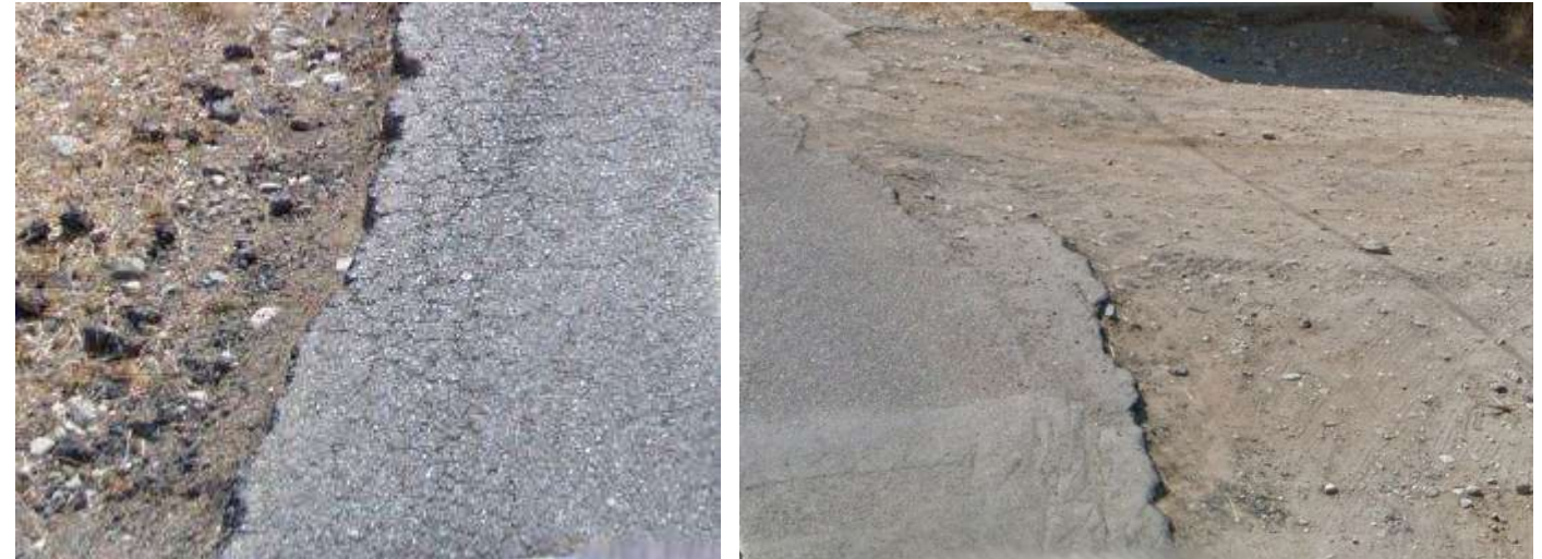
Exemples de portions d'enrobé dégradées sur la D238
