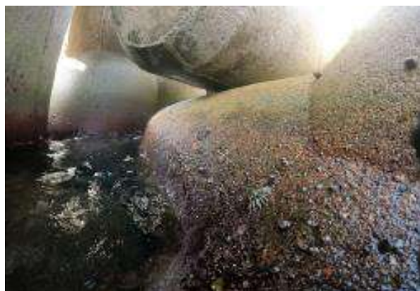
Exemple de digue en accropodes et présence du Grande Patelle entre les accropodes (SEMANTIC, 2023)
