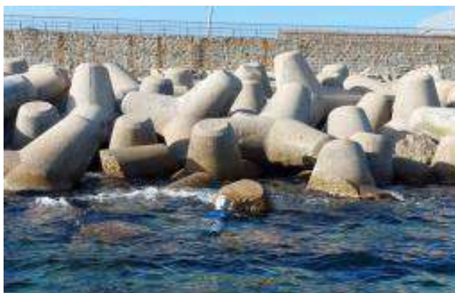
Exemple de digue en accropodes et présence du Grande Patelle entre les accropodes (SEMANTIC, 2023)
