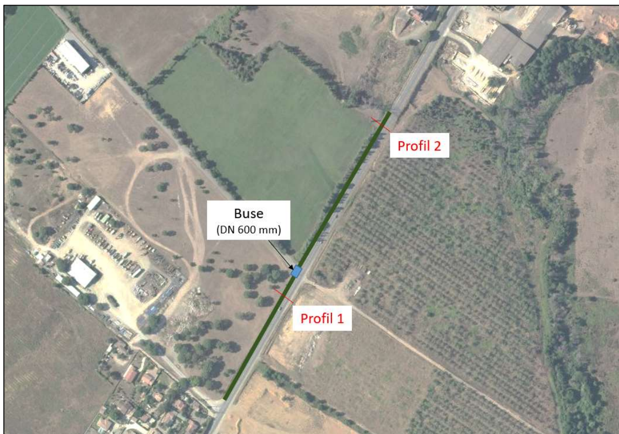
Illustration 15 : Evacuation des eaux pluviales
