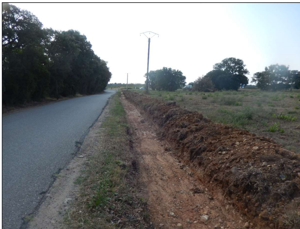
Photo 1 : Fossé nord (route communale)
