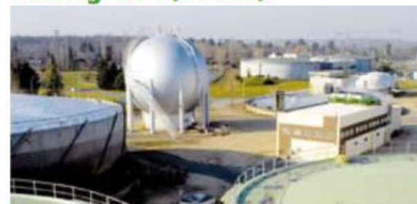
Exemple : la station d'épuration du SIAAP Seine Aval
