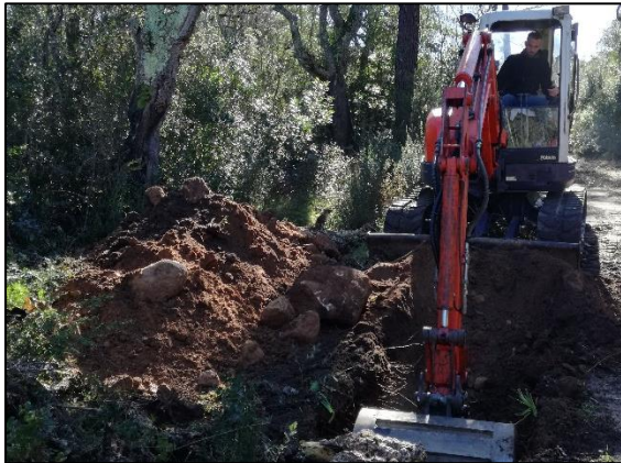
Photo 4 : Vue du sondage n°6
