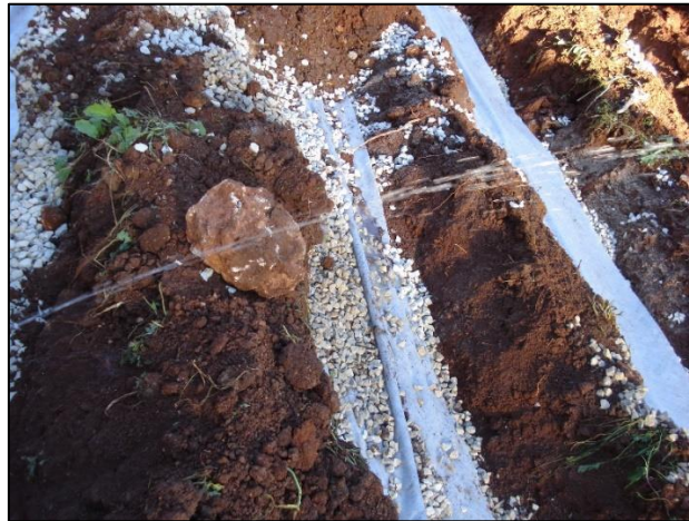
Figure 8 : Exemple de système d'irrigation en tranchée superficielle
