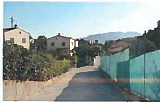
Logements de la partie Nord de Pietralba (source : Atlas des Paysages)
