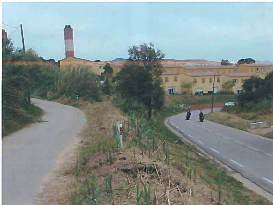
Figure 26 : Le Vazzino et la centrale EDF
