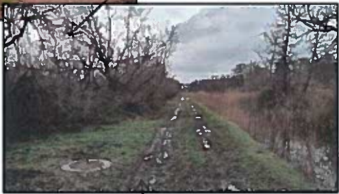
Passage de la nouvelle canalisation
