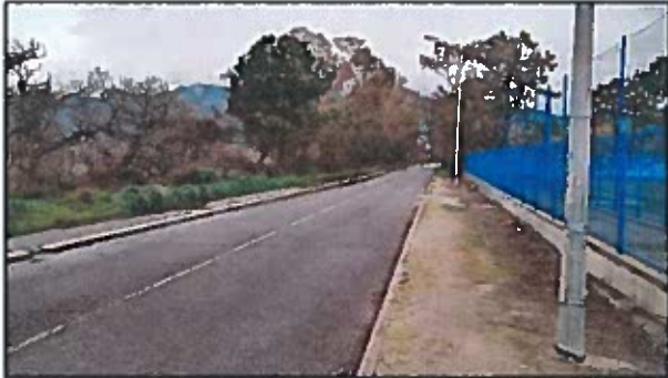
Passage côté mer de la route de la Lagune, en direction du PR Igésa (photographie du 05/03/2018)
