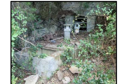
Exhaure anciennement captée du TB Guadiglio
