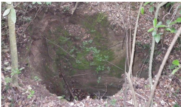
Exemple d'un effondrement localisé sur travaux mine de Luri-Castello
