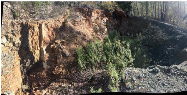
Exemple d'un effondrement localisé lié aux exploitations en dressant (mine d'Orzella – commune de Castineta)
