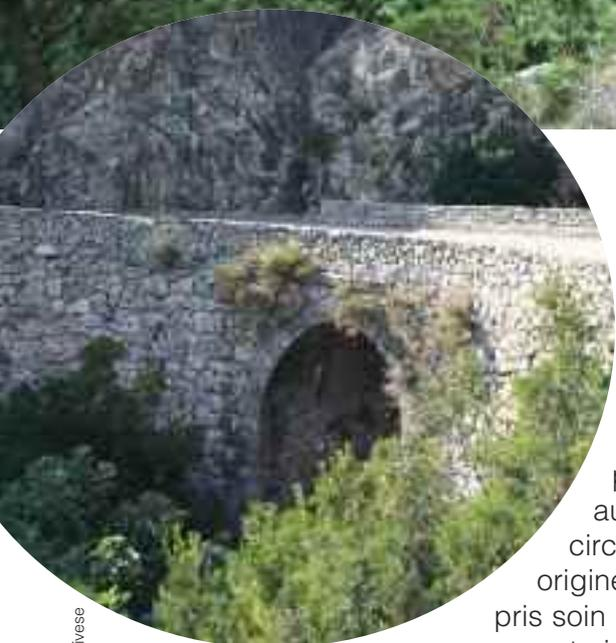
ainsi à Pinelli. Le pont n°3 a donné lieu à l'élargissement à 5 m de chaussée en mars 1993. Un fossé bétonné roulant et un trottoir avec revêtement en dalles ont été réalisés.
