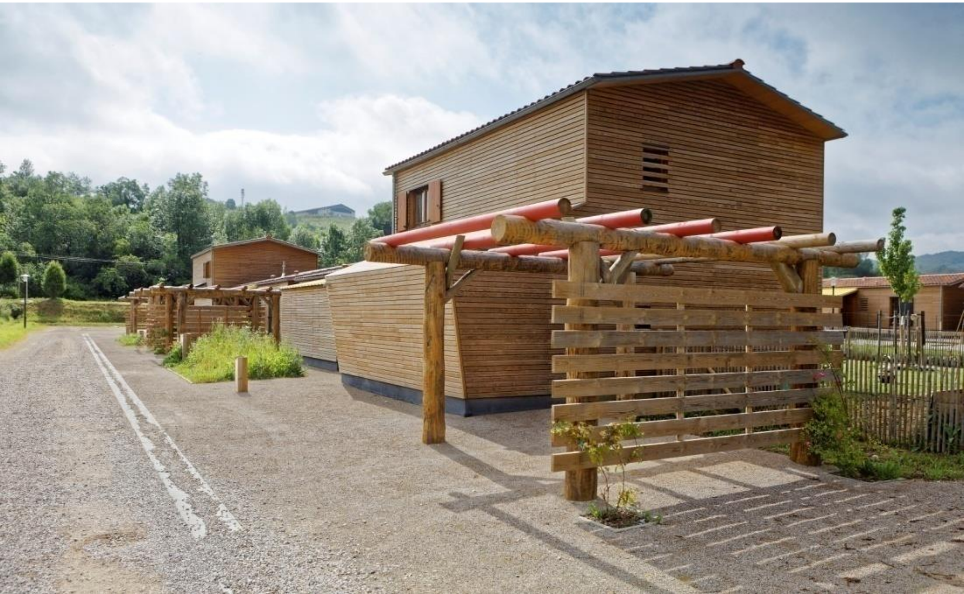
Sols perméables – réduction des hydrocarbures Rue nord côté village – T3 et T4 et parkings pergolas
