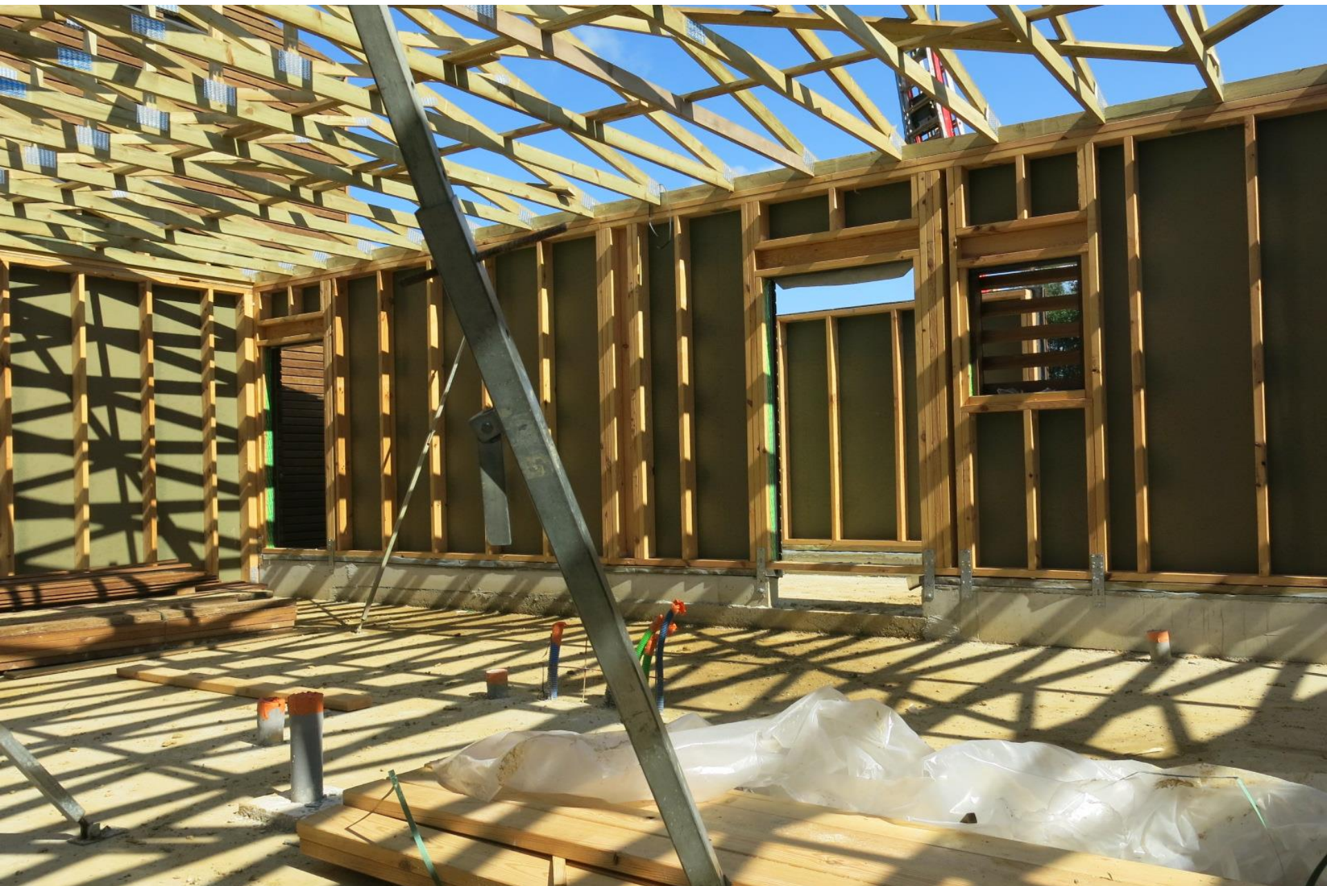
Constructions à ossature bois sur dallage béton
