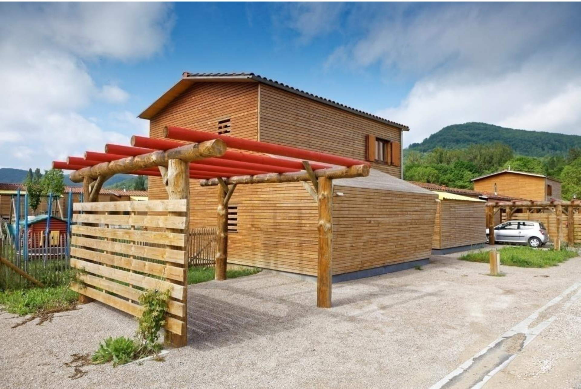
Faces nord éco quartier – accès des appartements – espaces tampons – celliers et pergolas parkings
