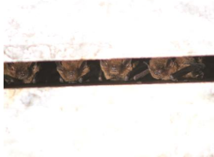
Des Pipistrelles communes dans un joint
