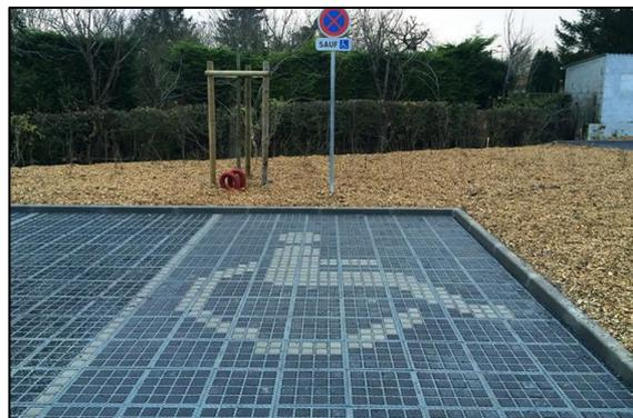
Figure 11 : Deux exemples de réalisation de parking perméable
