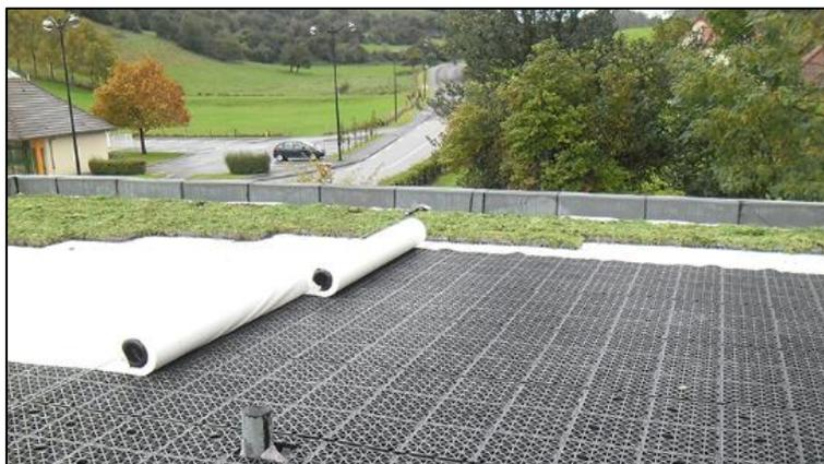
Figure 6 : Exemple de réalisation de toiture terrasse pour la retenue temporaire des eaux pluviales
