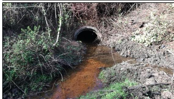
*Photo 6 : Traversée du chemin d'accès au projet, buse béton DN 1000*
