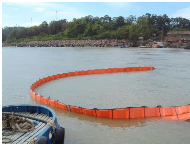
Installation d'un barrage flottant ( http://www.flexitankchina.fr )
