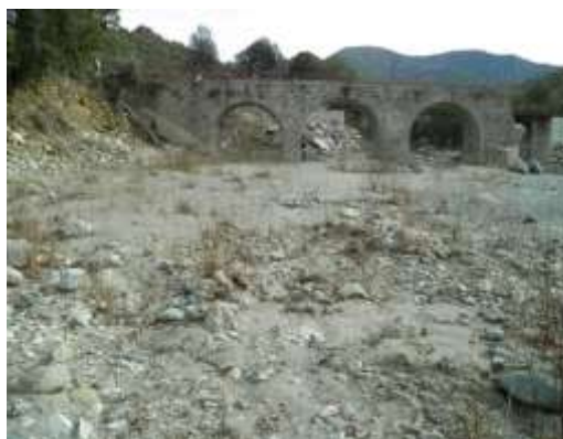
Berges en aval du pont
