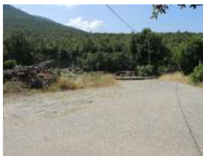
Route d'accès au pont avec bordures herbacées, favorables à de nombreux insectes communs.
