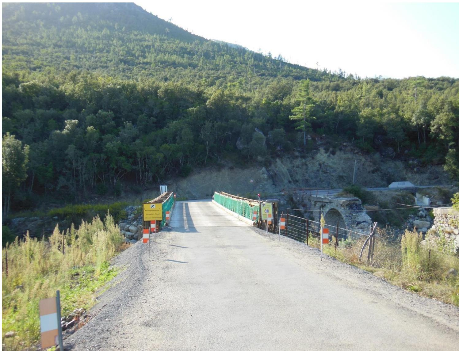
*Photo 1 – Pont de la Casaluna vu depuis le nord (Vue éloignée) – Sur la gauche de la photo, le pont provisoire – Sur la droite de la photo, le pont détruit par la crue de 2016*
