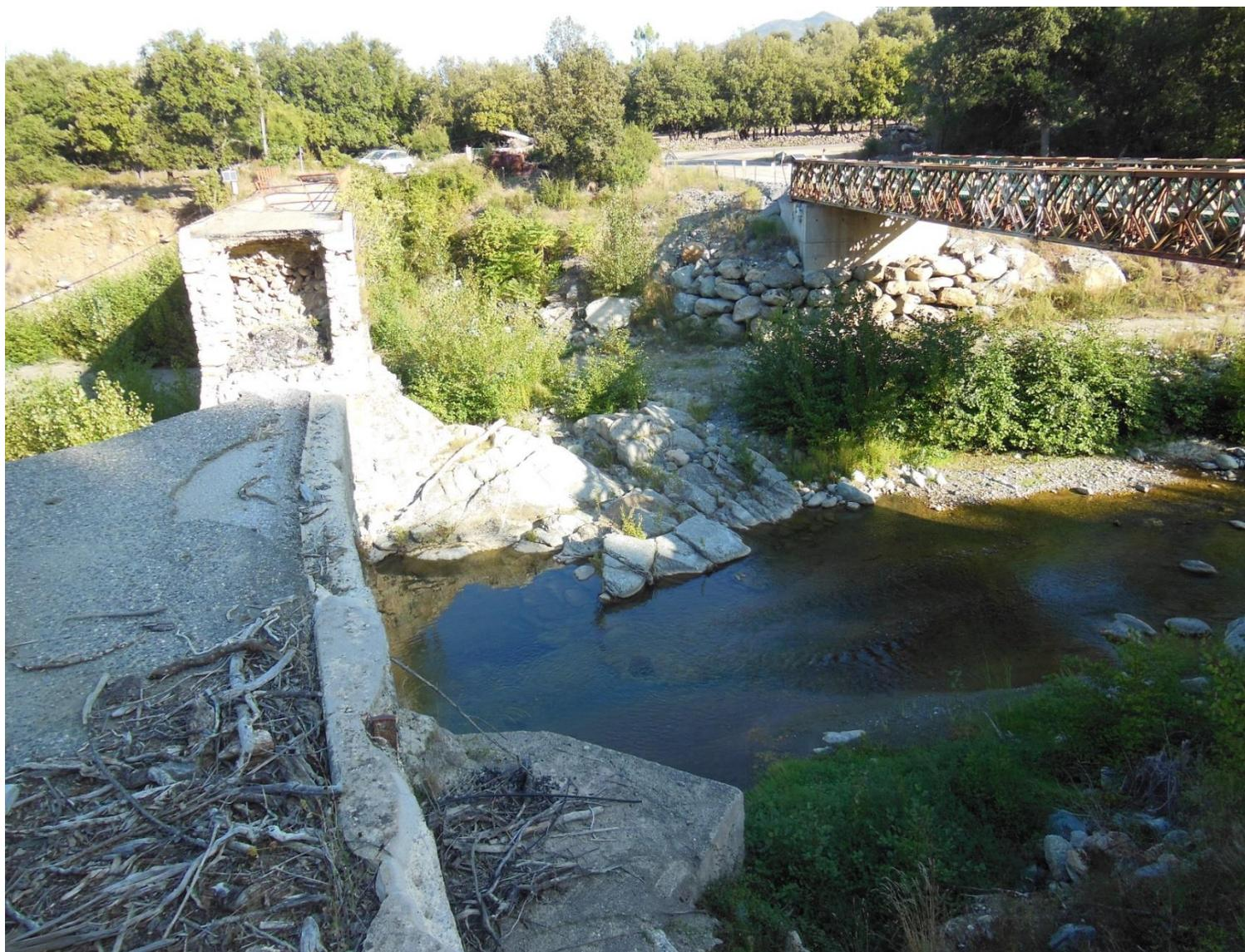
*Photo 2 – Pont de la Casaluna vu depuis le sud (Vue rapprochée) – Sur la gauche de la photo, le pont détruit par la crue de 2016 – Sur la droite de la photo, le pont provisoire.*
