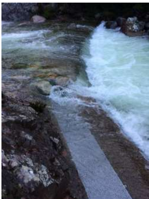
Figure 14 : nouvel équipement métallique au droit de la prise d'eau
