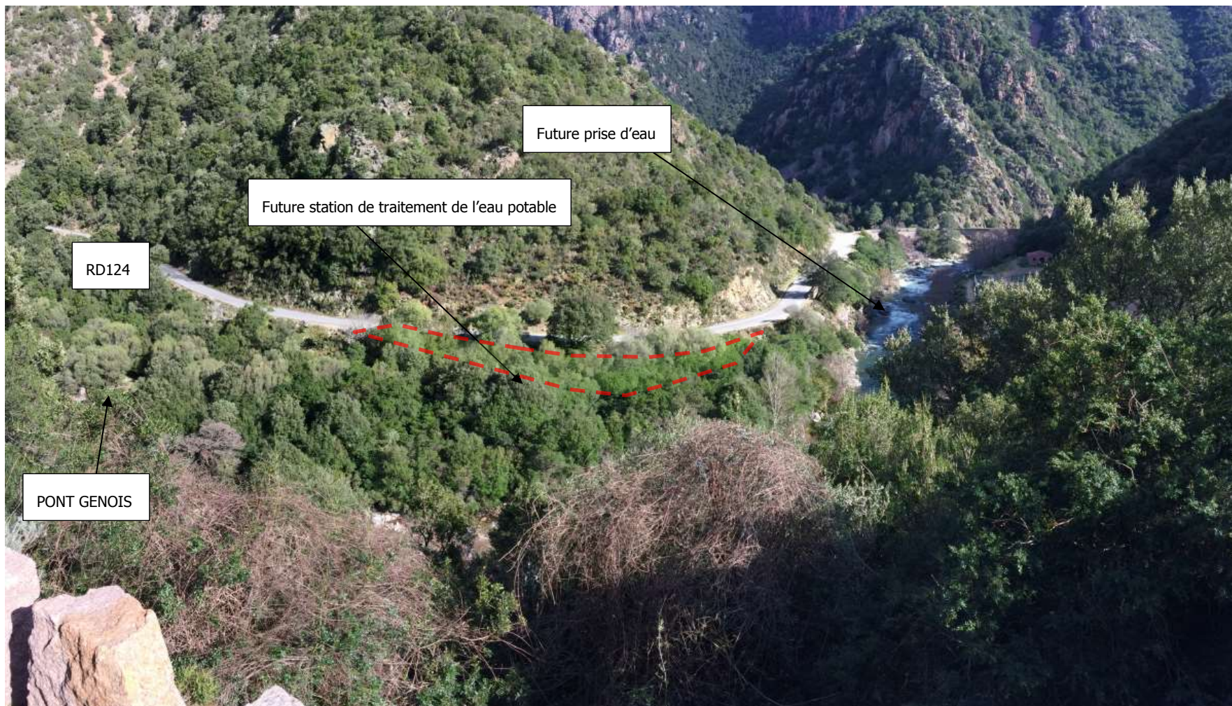
Vue du site depuis la RD 124 Sud
