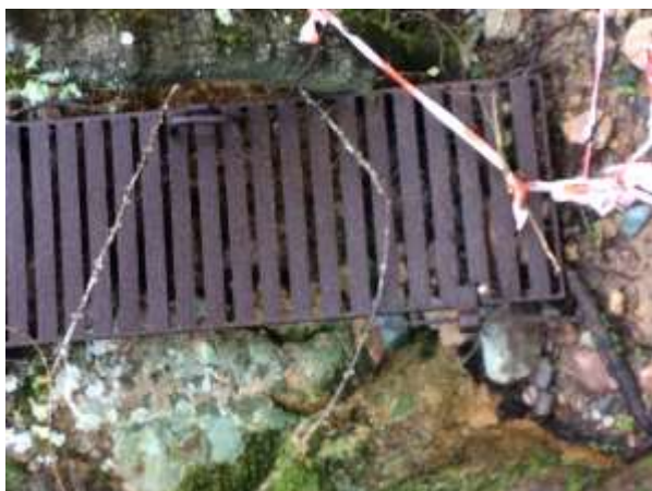
Figure 13 : Ancien équipement métallique
