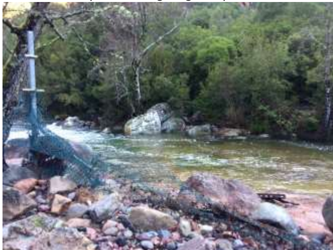
Figure 12 : poteaux et grillage de protection près de la prise d'eau
