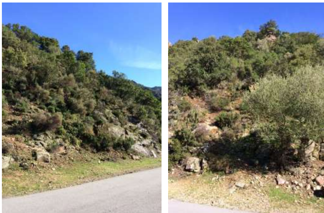
Aperçu du secteur surplombant la station de traitement.
