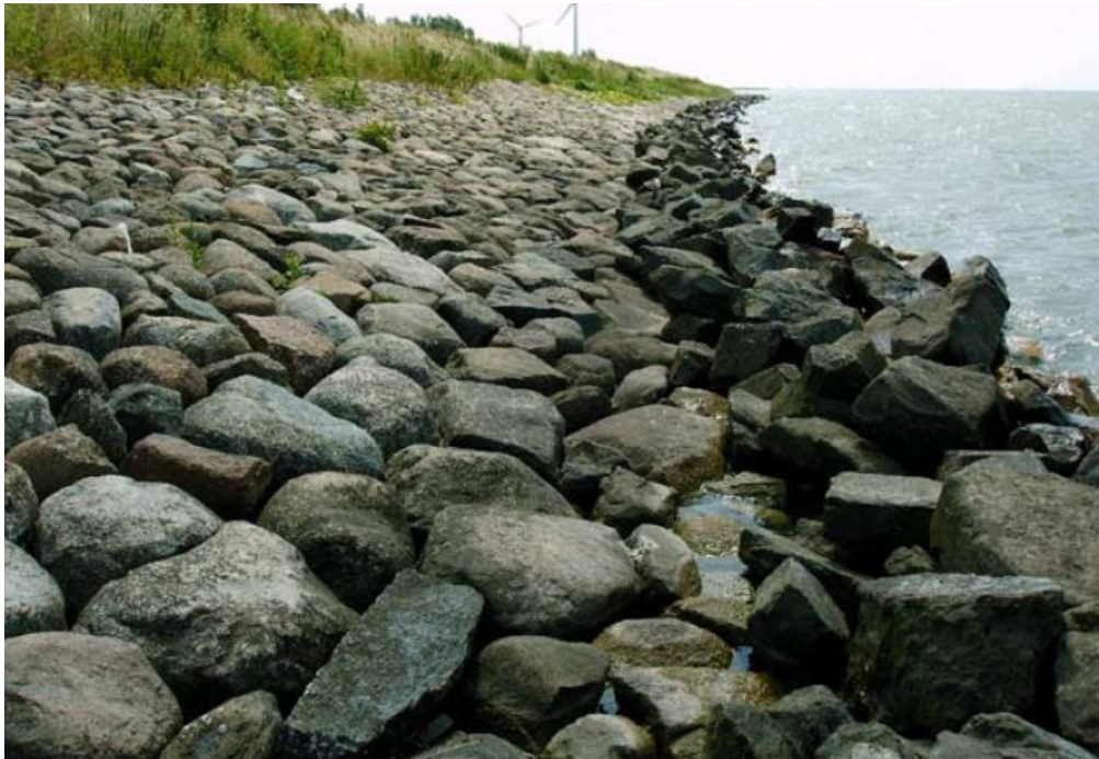
Figure 15 – Comparaison de pose de blocs « pavé arrangé » et aléatoire (Stability assessment of single layers of orderly placed and of pitched natural rock)
