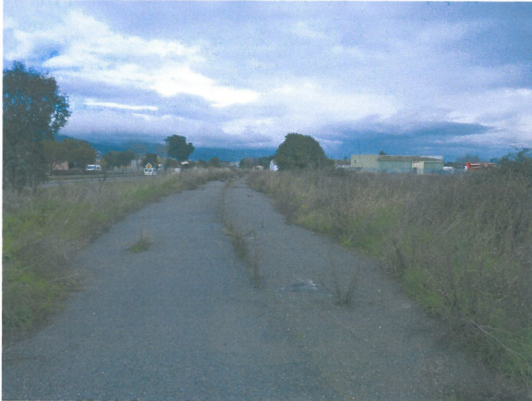
Photo n° 1 Voie d'accès existante
