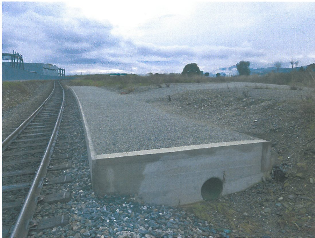
Photo n° 3 Vue d'ensemble du quai existant
