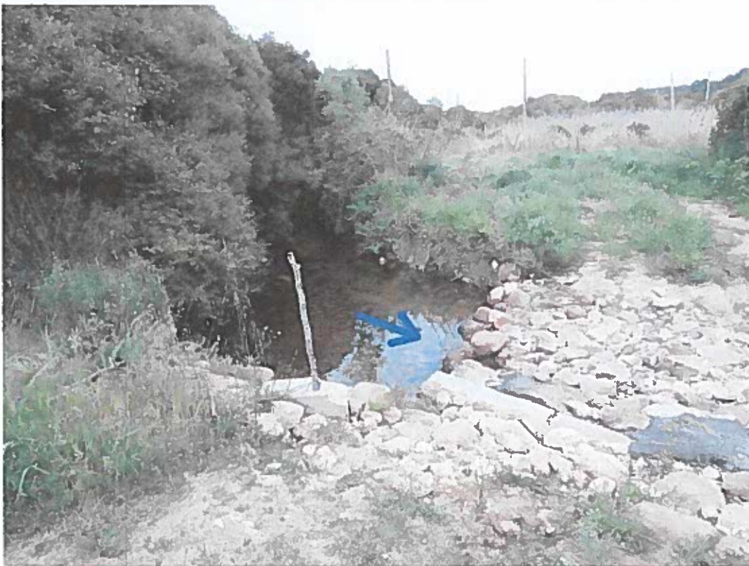
Photo 2 : Vue amont du passage
