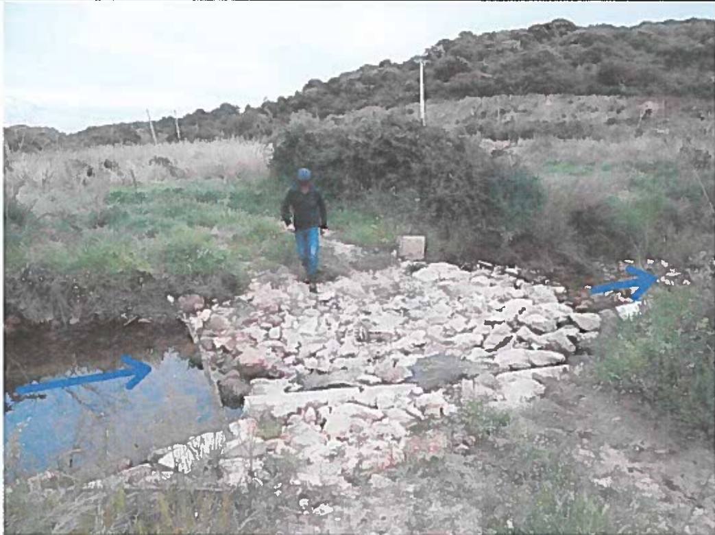
Photo 1 : Vue passage busé
