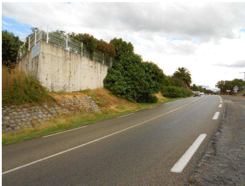
Photo n°3 – Mur de soutènement Ouest, Virage (R=150m)
