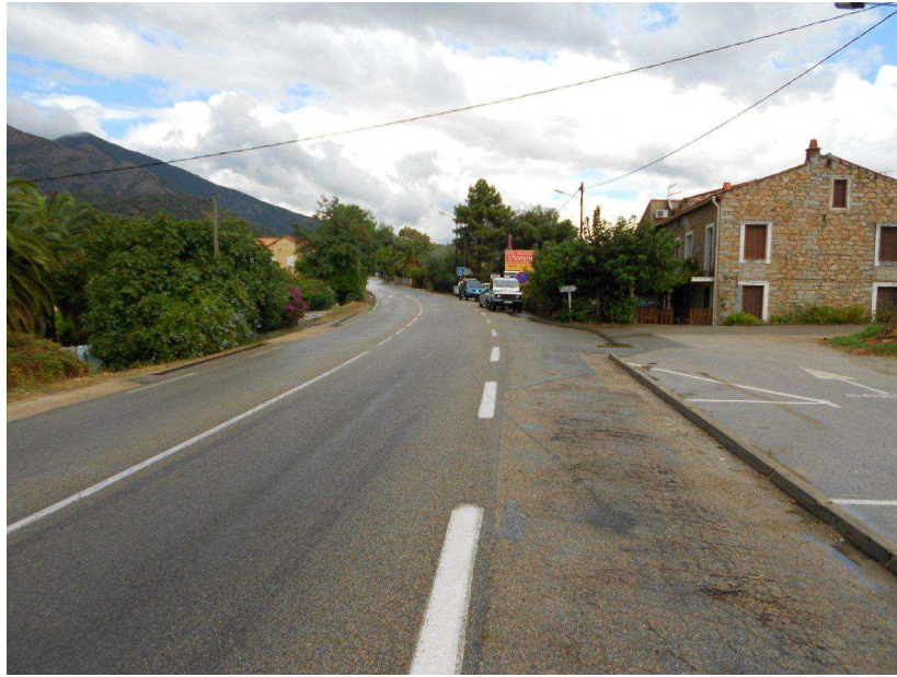
Photo n°5 – Virage (R=300m) devant le SPAR, puis emprise limitée
