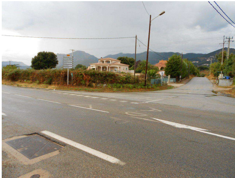
Photo n°10 – Carrefour avec la RD 361
