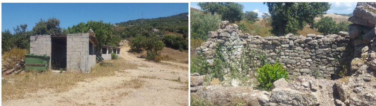
A gauche bâtiment "buvette, ID_13", à droite cabanon en pierre (ID_26)
