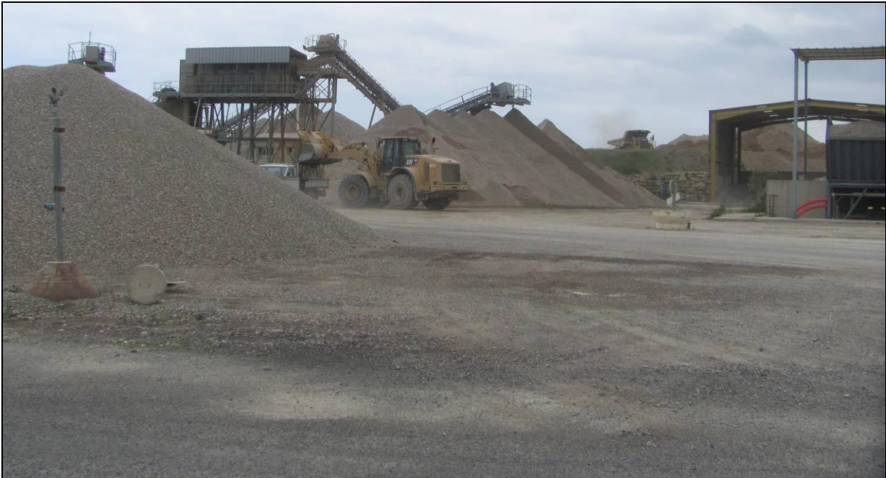
Aperçu des installations, au sein de la zone d'étude
